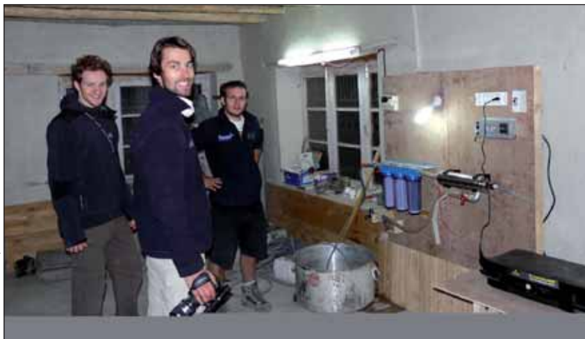
Les purificateurs d'eau sont installés au village de Skyu (Parc national d'Hemis)
